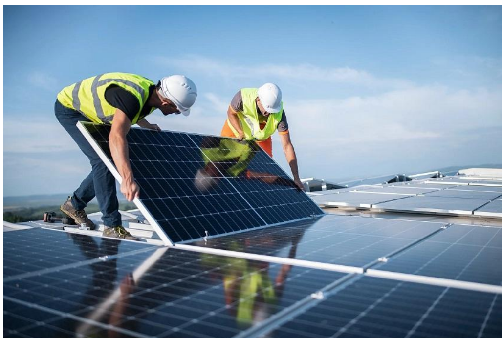
Figura 7 – Instalação de sistema fotovoltaico para autoconsumo
