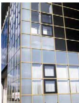
Figura 8.7 - Sistema solar de aquecimento ambiente numa loja de mobiliário com substituição parcial de fachadas (fachadas sul e oeste)
