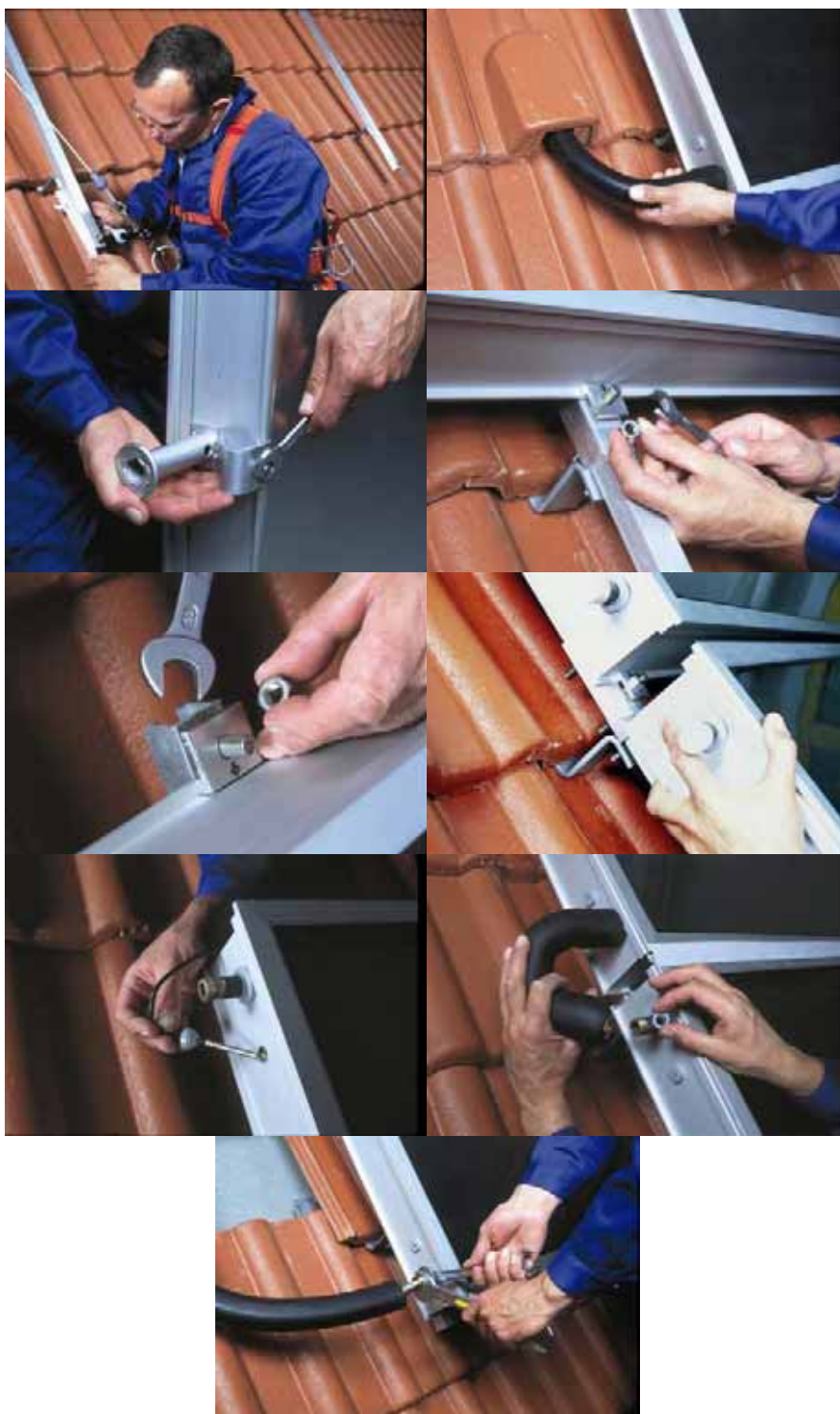
Figura 5.5 - Instalação sobre o telhado
