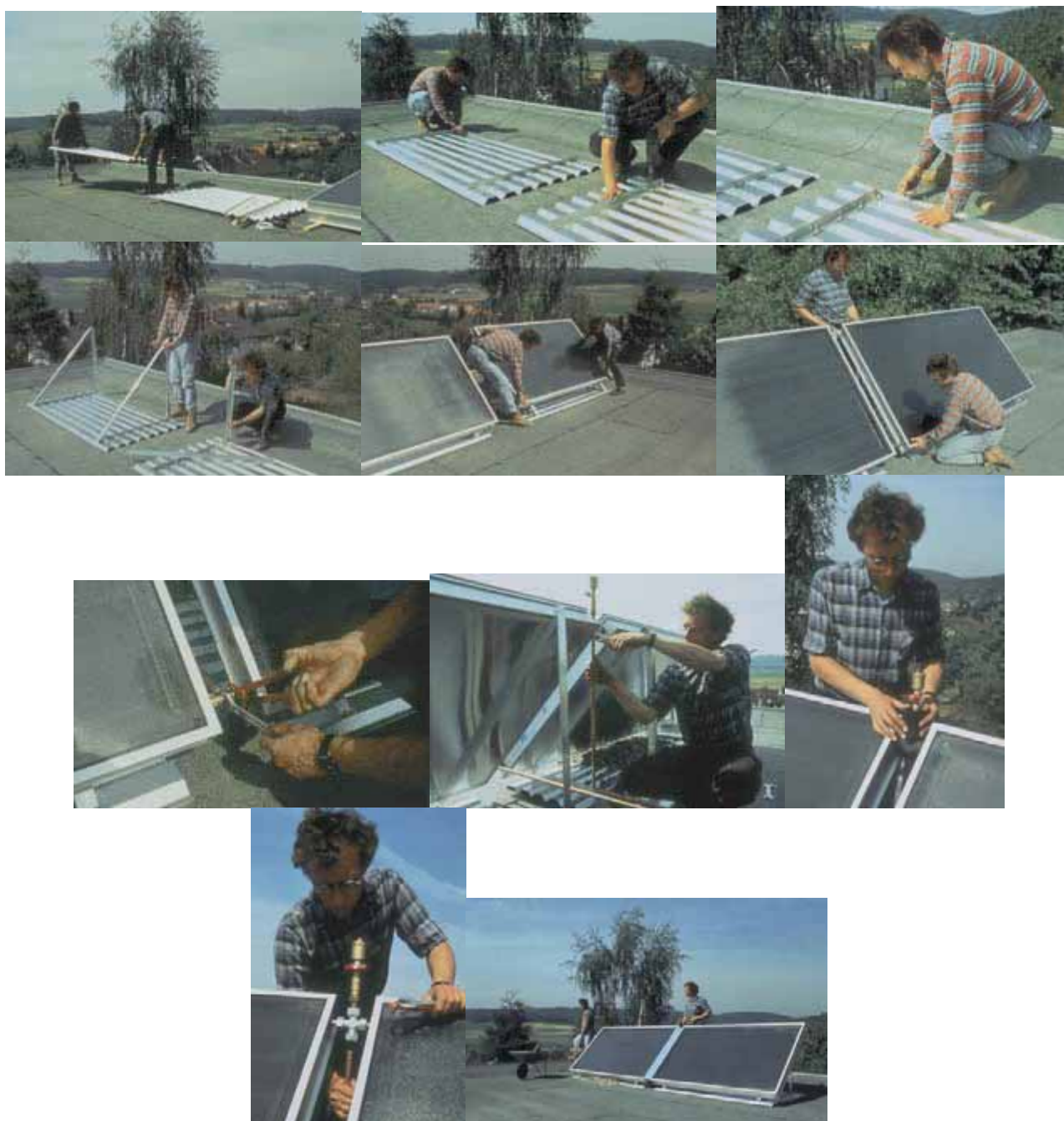
Figura 5.7 - Instalação em telhado plano
