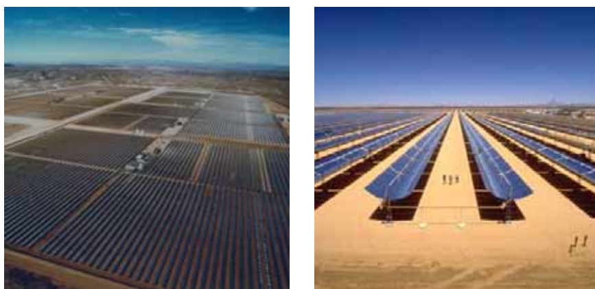
Figura 6.24 - Central com Concentradores “Trough” na Califórnia
