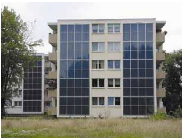
Figura 5.10 - Instalação em fachada de uma grande superfície de colectores em Bielefeld
