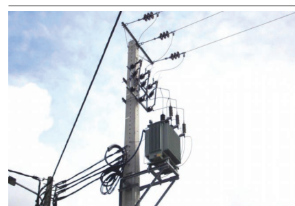
Figura 2 · PT aéreo do tipo AI, com saída também aérea do lado da BT.
