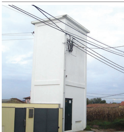
Figura 1 · Posto de transformação tipo cabine alta – 15 kV.
