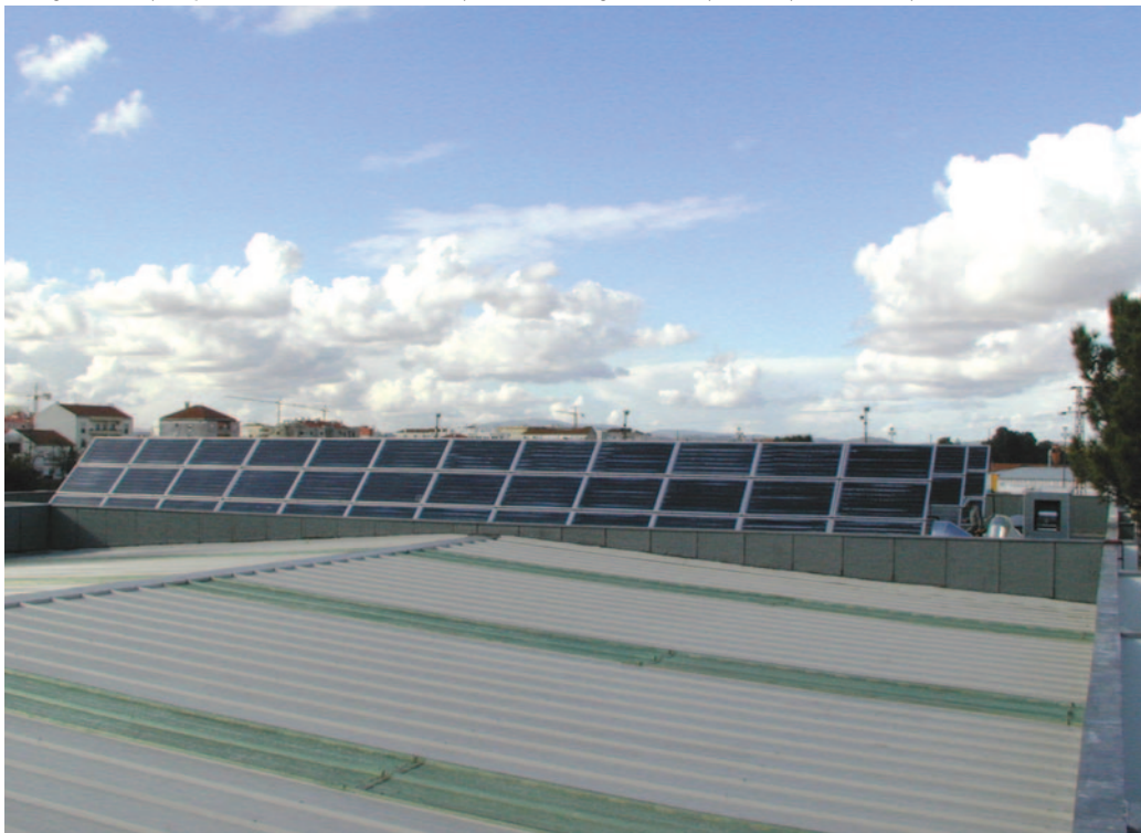
▼ Figura 15 - Aplicação de Colectores Solares de Aquecimento de Água num Pavilhão Gimnodesportivo.
