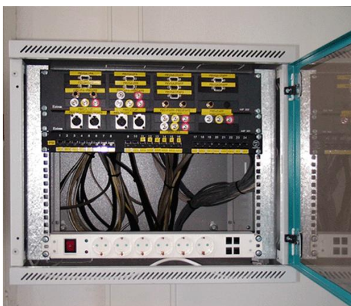
Figura 66- Bastidor de parede e sistema de ventilação
