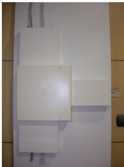
Figura 46 – Coluna e transição com calhas, calha e cantoneira para ângulo exterior
