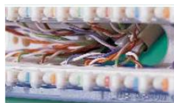
Figura 59 – Exemplo de unidades modulares em par de cobre, categoria 6
