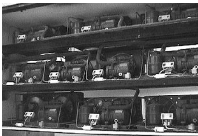
Figura 2 – Deficiente colocação dos condensadores das unidades refrigeração
