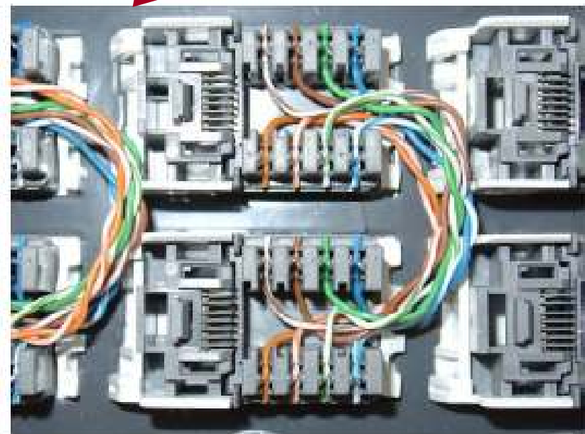
Figura 28 – Exemplo de um paralelo entre 2 tomadas RJ45
