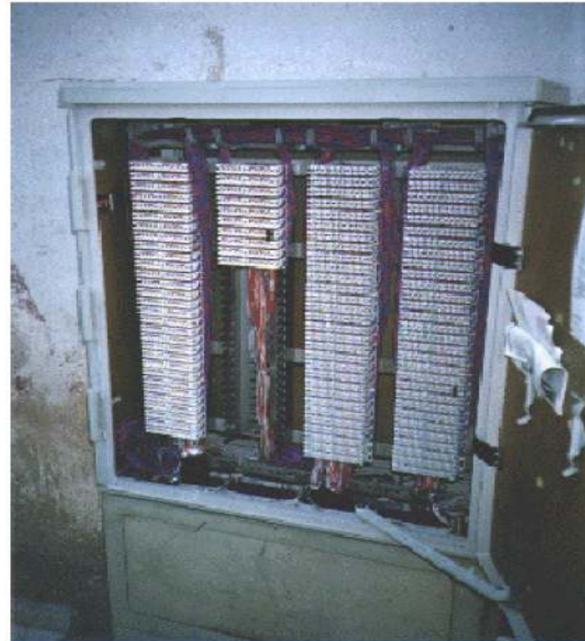
Figura 34- Exemplo de um RG-PC colocado em pedestal
