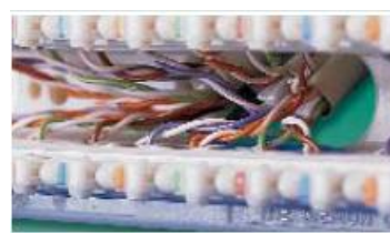
Figura 57 – Exemplo de unidades modulares em par de cobre, categoria 6
