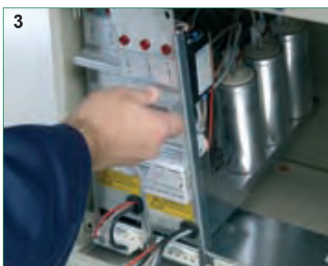
3 Sacar el módulo a sustituir
