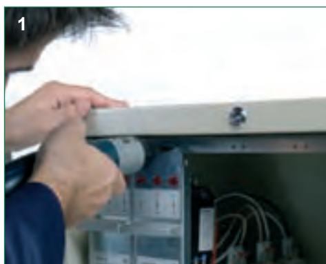
1 Retirar 2 tornillos de sujeción
